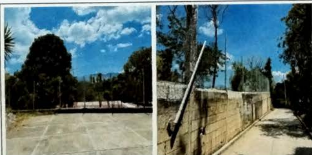
Foto 11: TRABAJOS EXTERIORES Vista de muro perimetral a base de bloco y malla metalica
