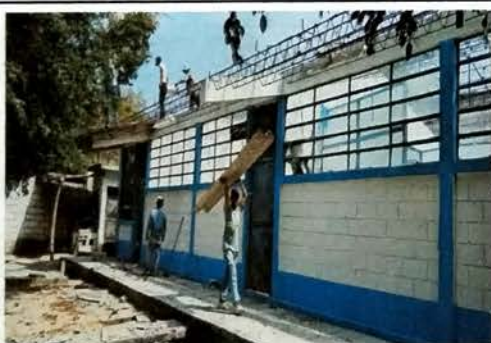
Foto 3: MODULO A vista de estructura ya con cubierta de asbesto desmontada.
