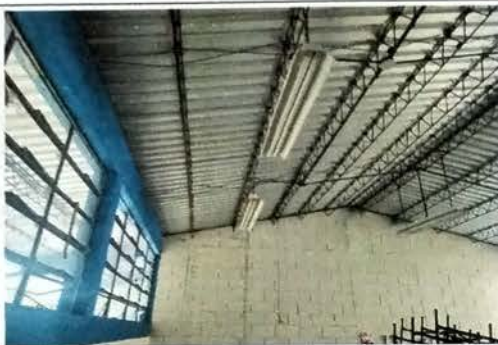
Foto 7: MODULO A Vista interior de aula donde se dio mantenimiento a estructura de metal a base de Joist.
