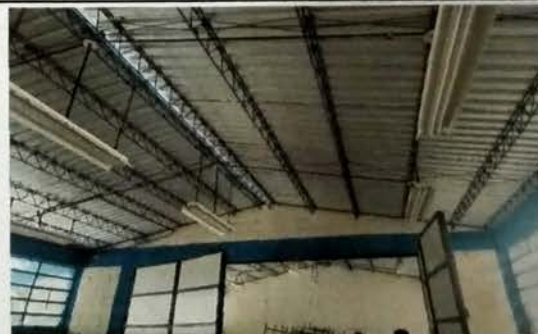
Foto 6: MODULO A Vista interior de aula con mantenimiento de estructura a base de Joist y cubierta de lamina troquelada cal 26.
