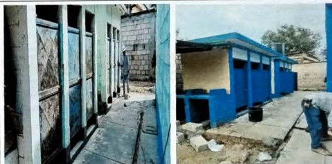
Foto 8: MODULO SERVICIOS SANITARIOS mantenimiento de puertas de metal y pintura de modulo.
