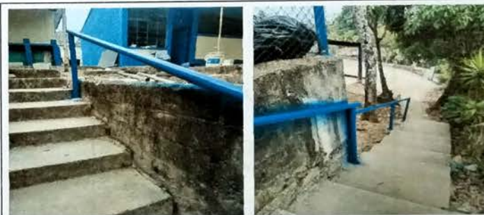
Foto 10: VISTA DE BARANDA METALICA en gradas existentes.
